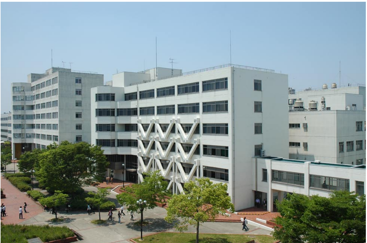
図書館屋上よりC棟とD棟
