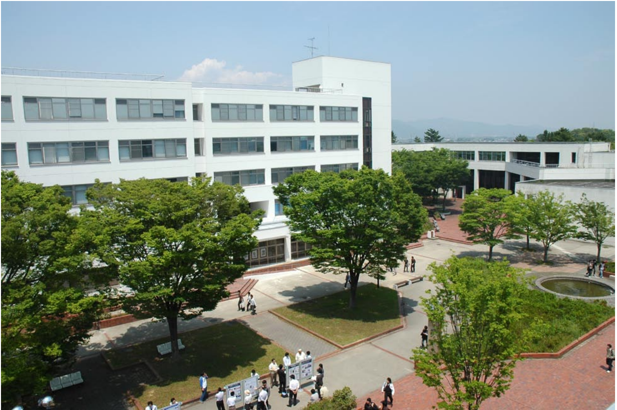
図書館屋上よりA棟とB棟
