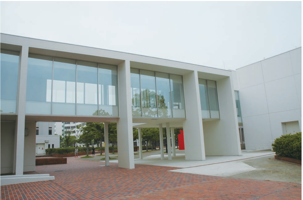
A棟に新設された渡り廊下
