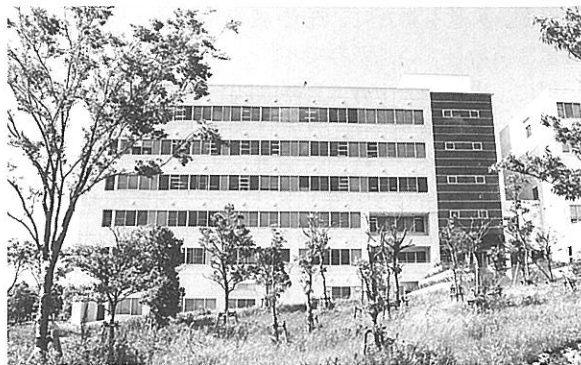
エコロジー工学教官研究棟の全景
